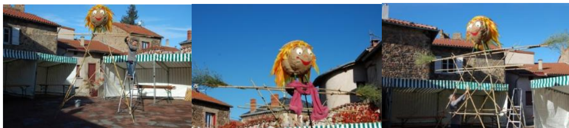
Montage de la structure
